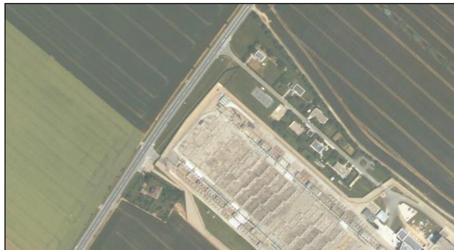
Figure 11 : Photo aérienne de site où les 7 logements ont été démolis : 6 sont au nord de la centrale électrique et ont été démolis en 2011 ; un pavillon est au sud-ouest et a été démoli en 2006 (source : photo aérienne 2005 Géoportail)
